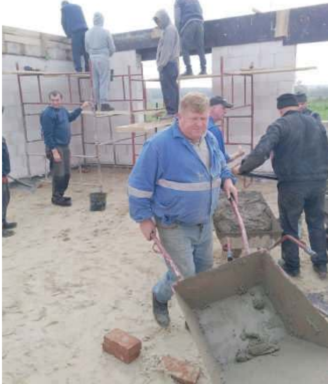
W Katarzynie powstaje miejsce, które ma służyć wszystkim mieszkańcom. Budują świetlicę czynem społecznym!
