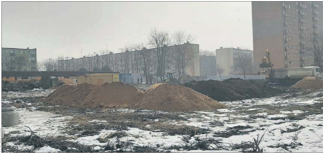
Pierwsze wykopy na budowie nowej siedziby przedszkola nr 17 przy ul. Kossobudzkiego
