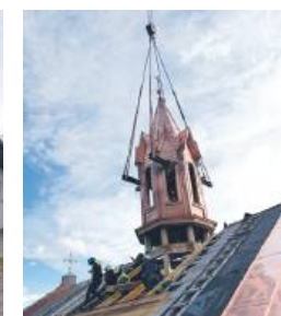
Remont wieżyczki kościoła
