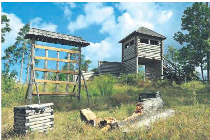
Po nawałnicy. Zniszczone tablice, obrysy chat, a także wejście na wieżę. Fot. archiwum
