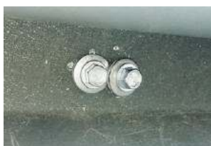
Po naprawach reklamacyjnych w dachu zostało 35 dziur zaczopowanych metalowymi wkrętami.
