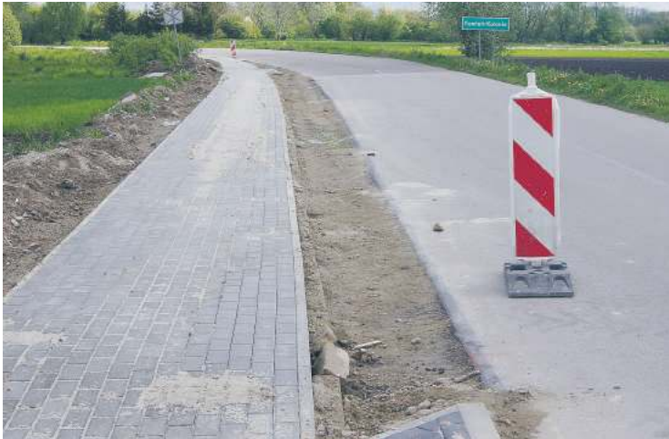
Modernizacja drogi w Kamieniu-Kolonii
