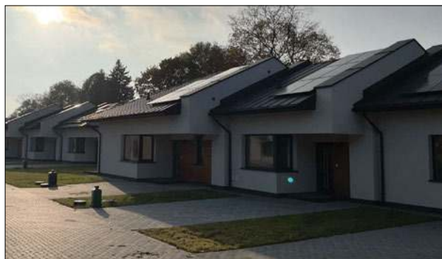
Realizacja projektu pod nazwą „Budowa mieszkań komunalnych w Gminie Rossosz” zaowocowała wybudowaniem kompleksu mieszkań o różnym metrażu, o powierzchni od 40 mkw., poprzez 55 mkw., do 70 mkw.
