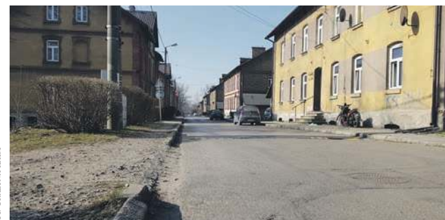
Obieżowa przed remontem
