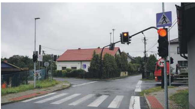
Na skrzyżowaniu ul. Zwycięstwa, Leśnej i Szczakowskiej w Trzebinii wybudowano przejścia dla pieszych, sygnalizację świetlną i wyremontowano chodniki
