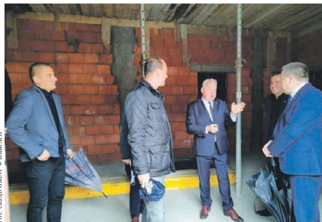
Podczas wizyty wiceministra Jacka Osucha w budowanej sali gimnastycznej w Jankowicach
