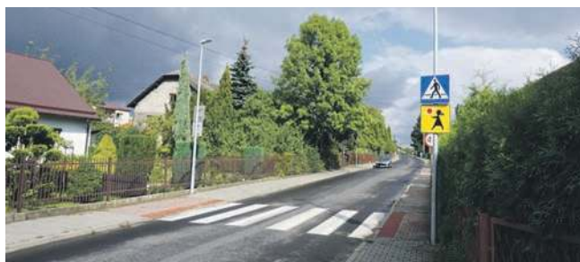
Doświetlono przejście dla pieszych na skrzyżowaniu ul. Sikorskiego, ul. św. Barbary i ul. Przyrodniczej w Libiążu
