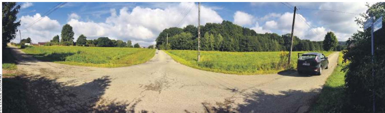
Asfalt na skrzyżowaniu Skalistej i Za Dworem w Porębie Żegoty został położony częściowo na gruntach prywatnych
