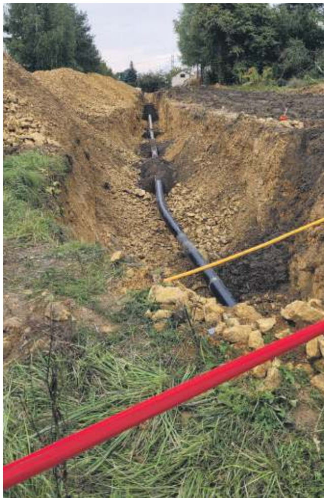
Wykop w okolicy ul. 1 Maja w Trzebinii
