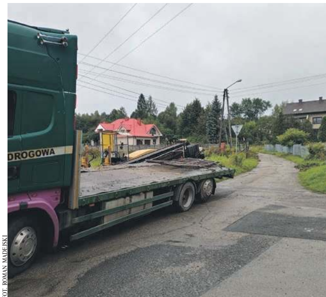
Rozpoczęła się modernizacja rurociągu na Brackiej na chrzanowskich Kątach
