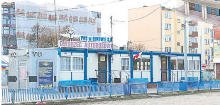
Stary kontener zastąpi...
