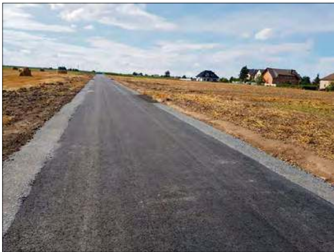
Koszt wykonania drogi to 311 tys. zł.
