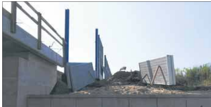
Obecnie montowane są ekrany akustyczne
