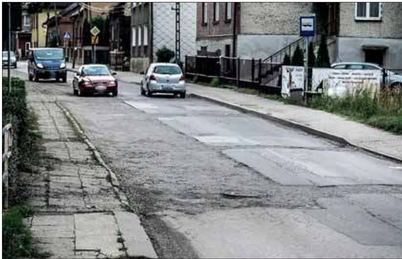
Droga ma zostać odnowiona po wybudowaniu nowej sieci wodociągowej
