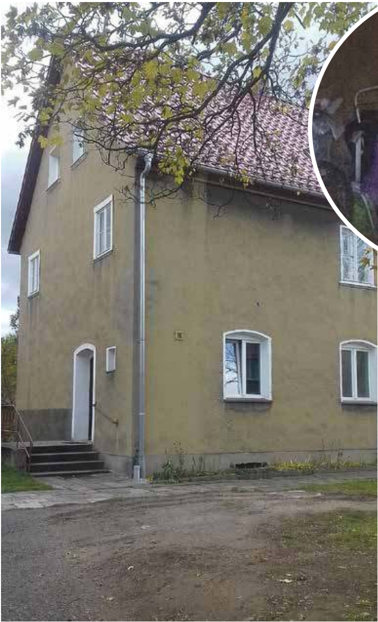
Blok na ulicy Staromiejskiej
