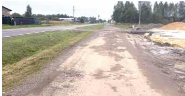
Droga serwisowa przy DW 835 na wysokości Gromady zostanie wyremontowana
