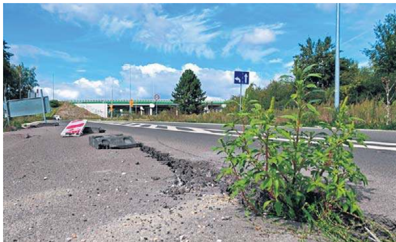
Tak piętnaście miesięcy po oddaniu do użytku prezentuje się odcinek drogi między Toruniem a Małgorzatem
