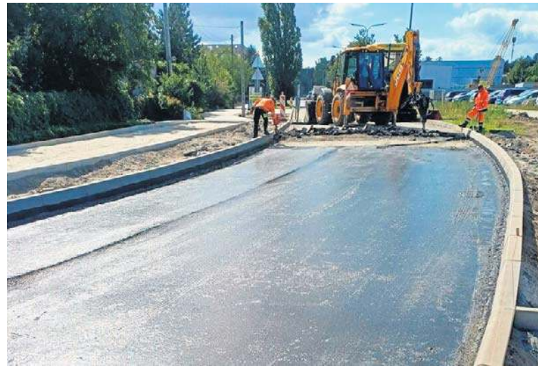
Prace na Osowej Górze mają potrwać do końca roku
