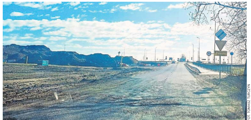
Droga dojazdowa z Warszkwowa do drogi ekspresowej S6 jest w kiepskim stanie. Wkrótce ma to się zmienić. Wykonawca ma 2 miesiące na remont drogi
