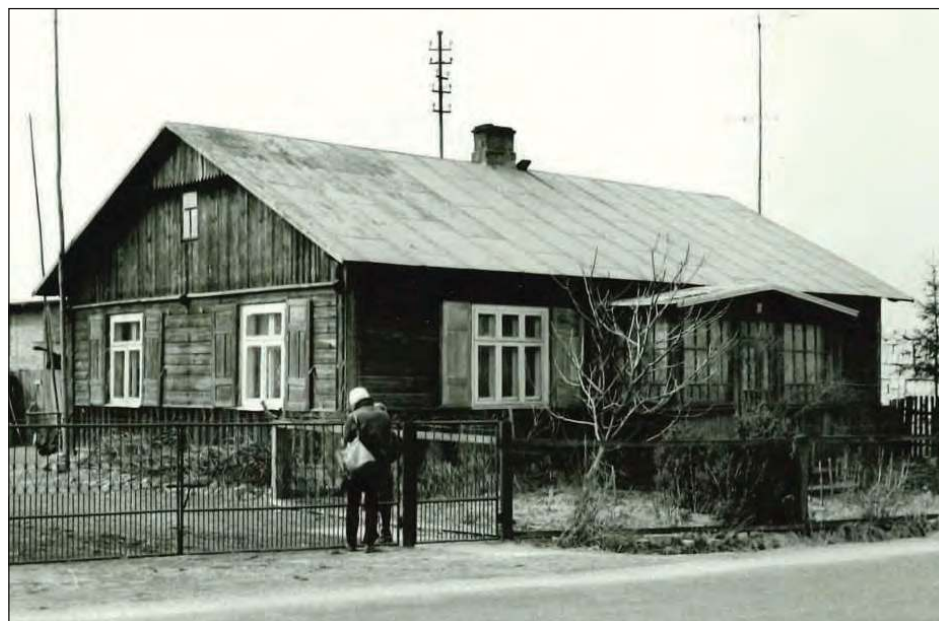
➦ Drażgów, jeden z domów „typu lokalnego” pokryty dachem dwuspadowym, przy trasie Ryki-Baranów (fot. Zbigniew Pastuszek)
