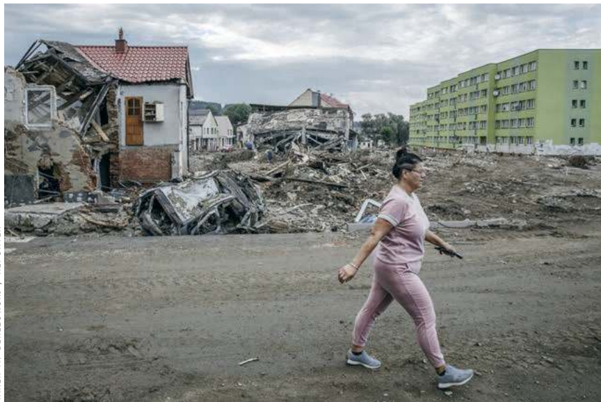
Stronie Śląskie po przejściu fali powodziowej
