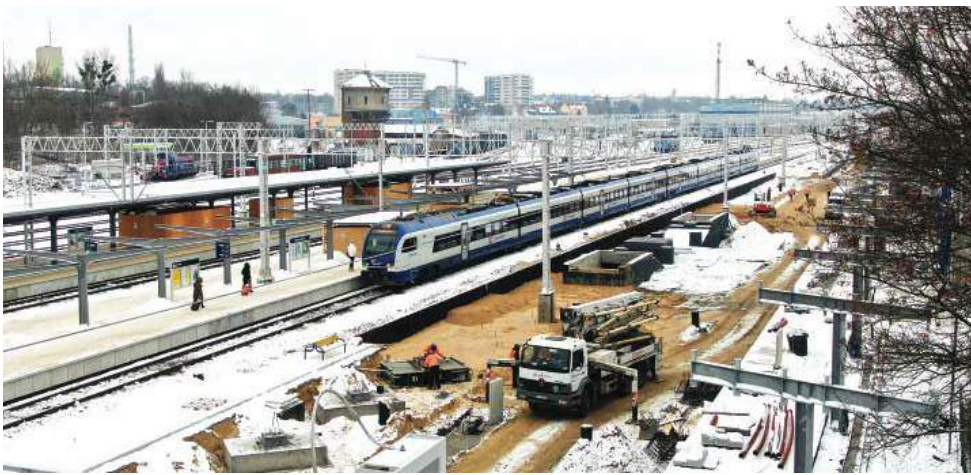
Zakończenie prac przy budowie nowego dworca PKP Olsztyn Główny planowane jest w pierwszych miesiącach 2024 roku
