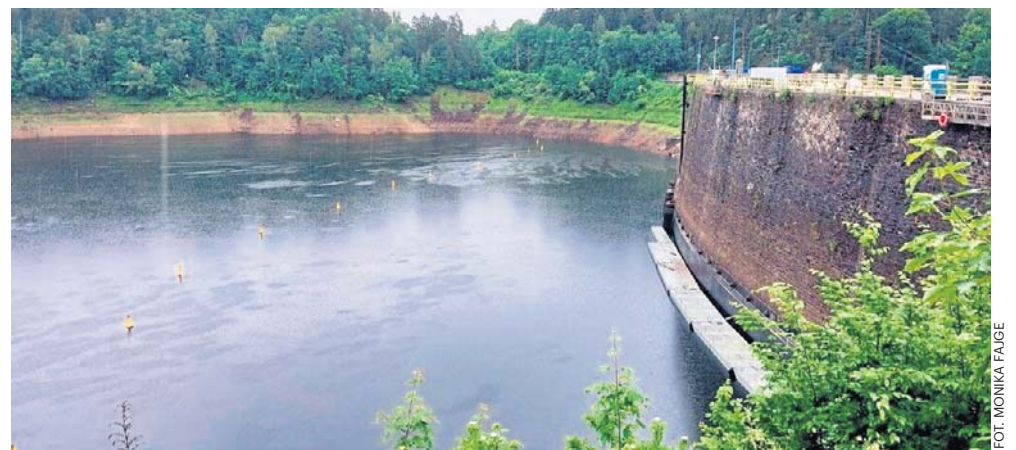
Wodę trzeba spuścić, żeby wyremontować ponad stuletnią zaporę, która chroni przed powodzią
