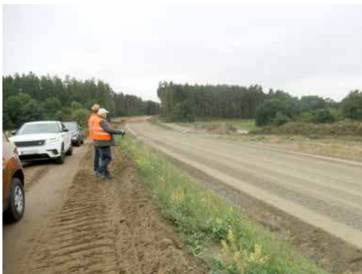
Budują obwodnicę i drogi dojazdowe
