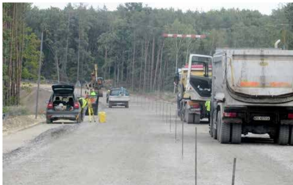
Przygotowanie do asfaltowania
