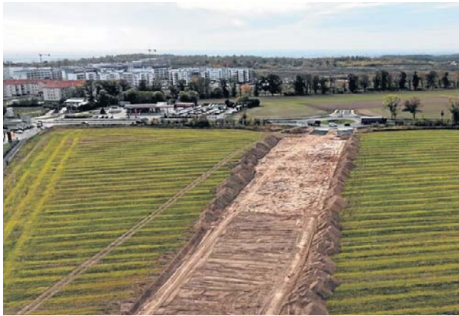
Miejsce połączenia budowanej północnej obwodnicy miasta z ul. Myśliborską będzie istniejące już rondo Schumana
