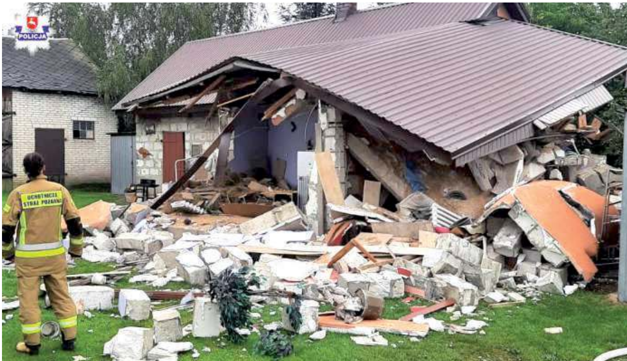
Po wybuchu butli z gazem dom runął. Przebywająca w budynku 74-letnia kobieta z obrażeniami ciała została przetransportowana śmigłowcem do Wschodniego Centrum Leczenia Oparzeń w Łęcznej. Jej życia nie udało się uratować
