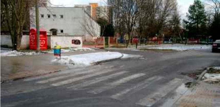
Mimo zapowiedzi urzędników, przejście wciąż nie jest oznakowane
