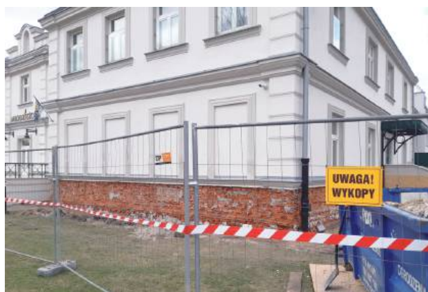
Wykonawca odkuł część elewacji budynku. To, co jeszcze niedawno było położone na ścianie obiektu jako nowa elewacja, teraz trafiło do kontenera jako gruz
