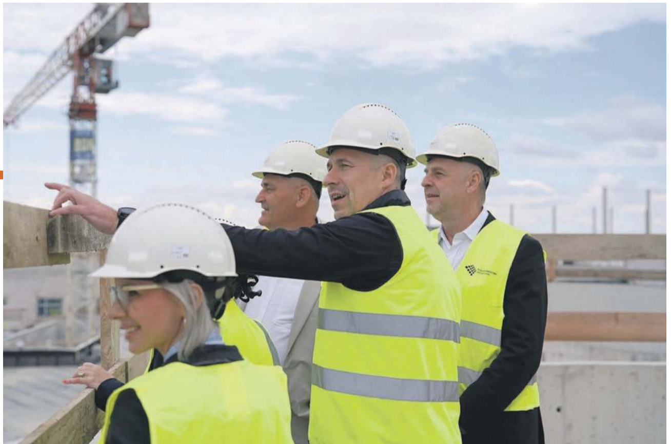
Marszałek Paweł Gancarz podkreśla, że Nowy Szpital Onkologiczny to największa inwestycja w zdrowie Dolnoślązaków. Tempo prac na budowie jest bardzo dynamiczne.
