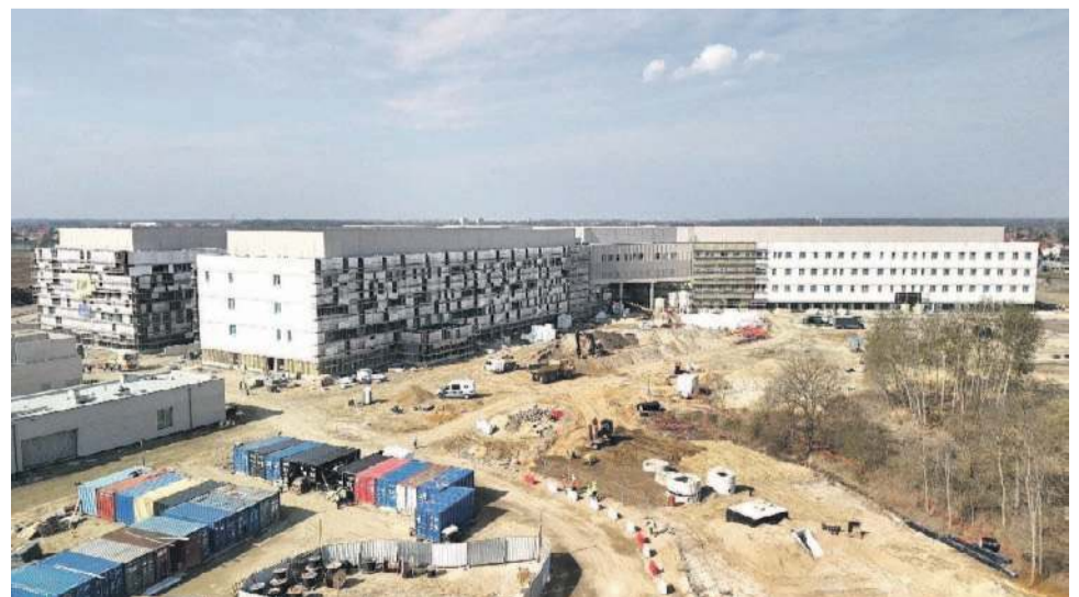
Budowa Nowego Szpitala Onkologicznego idzie pełną parą
