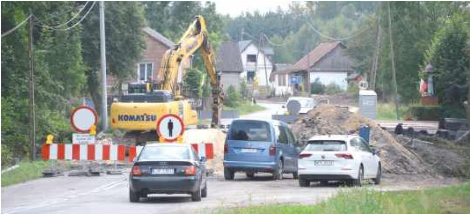
W Godowie rozpoczęła się rozbórka istniejącego mostu. W jego miejsce posadowiony zostanie nowy, odtworzona istniejąca konstrukcja drogi i wybudowany ciąg pieszo-jezdny
