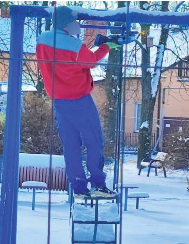
Na huśtawce, z elektryczną tarczą, bez drabiny i okularów. Słowem trwa remont na skwerze w centrum Biłgoraja
