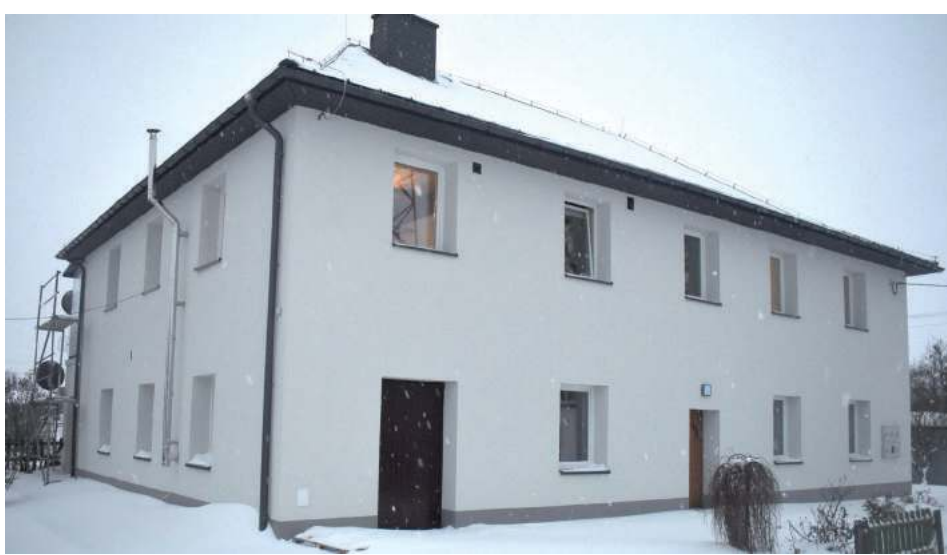
W Domu Nauczyciela w Byszczu wymieniono między innymi dach, okna, drzwi oraz wykonano termomodernizację ścian, docieplenie i nową elewację
