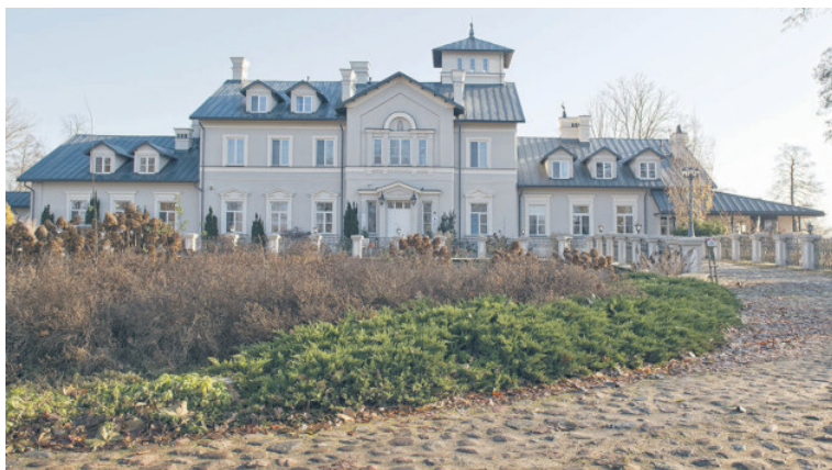
Pałac w Trojanowie
