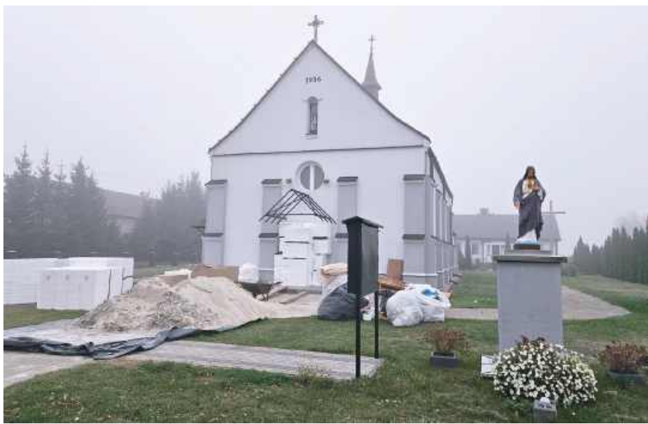
Trwają już prace przy zabytkowym kościele pod wezwaniem Niepokalanego Poczęcia NMP w Kożuszach
