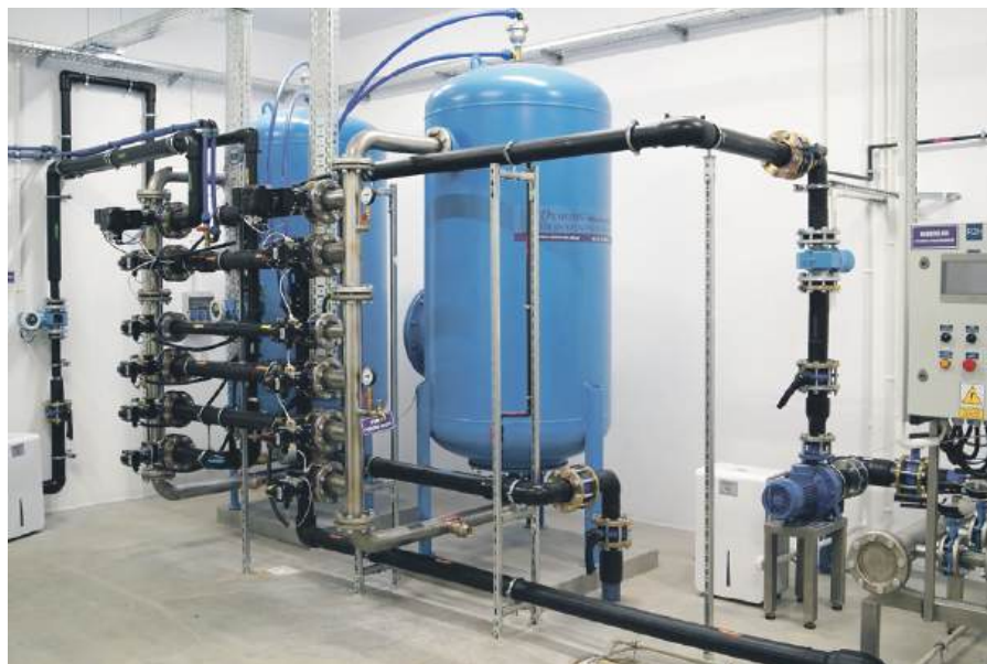
Stacja Uzdatniania Wody i przebudowa magistrali to kluczowe inwestycje dla mieszkańców Gminy Wiązów
