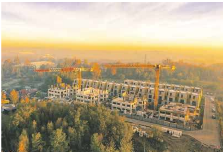
W lutym ruszyła budowa II etapu Osiedla Bolko i już część mieszkań została sprzedana.
