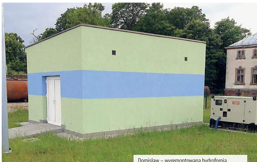
Domisław – wyremontowana hydroforna
