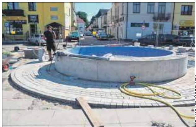
W ostatnich tygodniach w centrum modernizowanego Rynku trwa montaż fontanny
