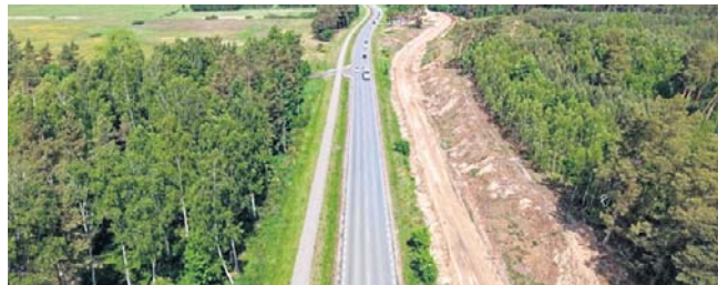
Tak wygląda przebudowa linii kolejowej 229 i 230 z lotu ptaka. Zakończenie inwestycji planowane jest w 2029 r.
