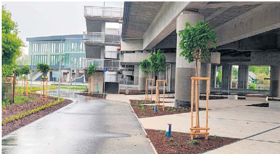
Tak prezentują się drzewka pod nowym wiaduktem w Radomiu, które mają rosnąć bez dostępu do słońca i wody deszczowej.
