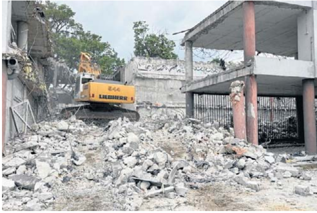
Trwa rozbiórka parkingu w centrum Radomia przy ulicy Kelles-Krauza. Jest coraz więcej gruzu.
