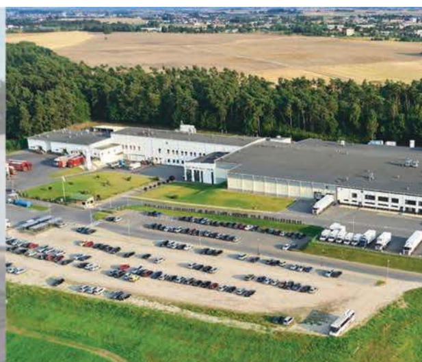
Ubojnia Trzody Chlewnej w Chojnicach.
