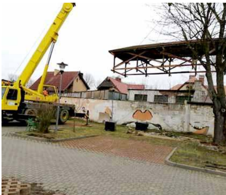
Trwają prace przy realizacji projektu pn. Rewitalizacja Centrum Dolic.
