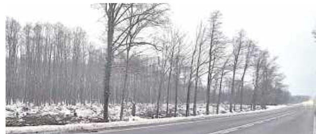
Rozpoczął się wyręb lasu pod budowę drogi ekspresowej S19. Szykowane jest miejsce na drugi pas ekspresówki, drogę dojazdową, przejścia dla zwierząt. Zostanie zniwelowany teren o szerokości ok. 40 metrów, w niektórych odcinkach nawet o 70 metrów
