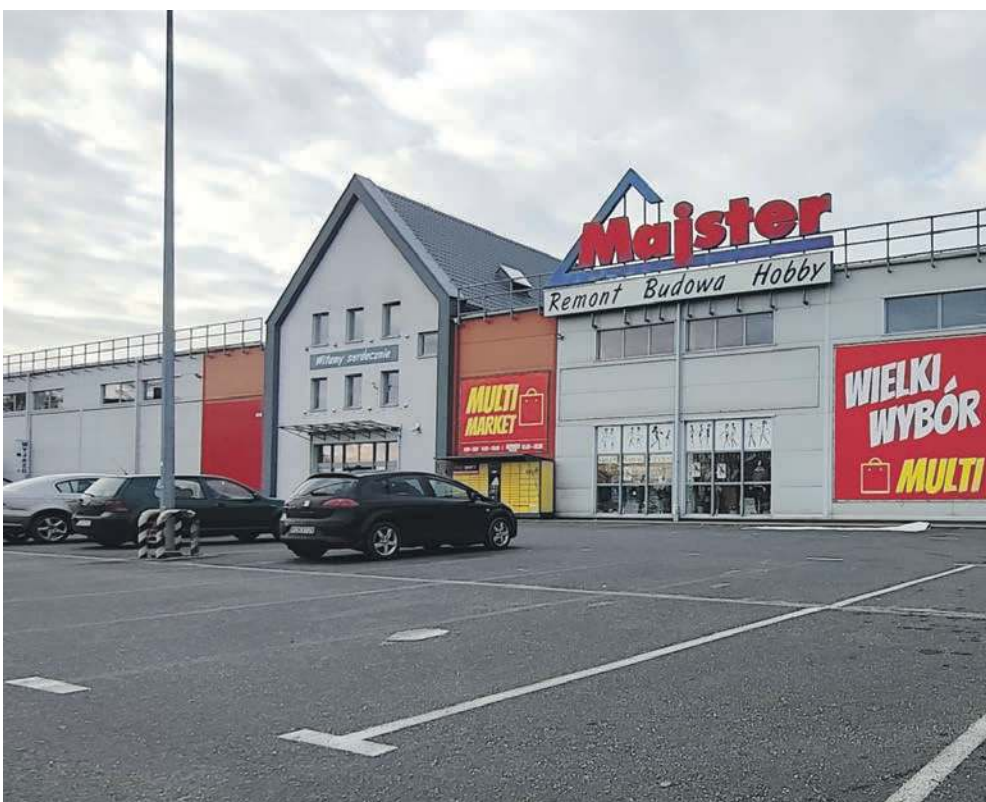
Trwa remont pomieszczeń po zlikwidowanym Majstrze przy Długiej w Trzebini
