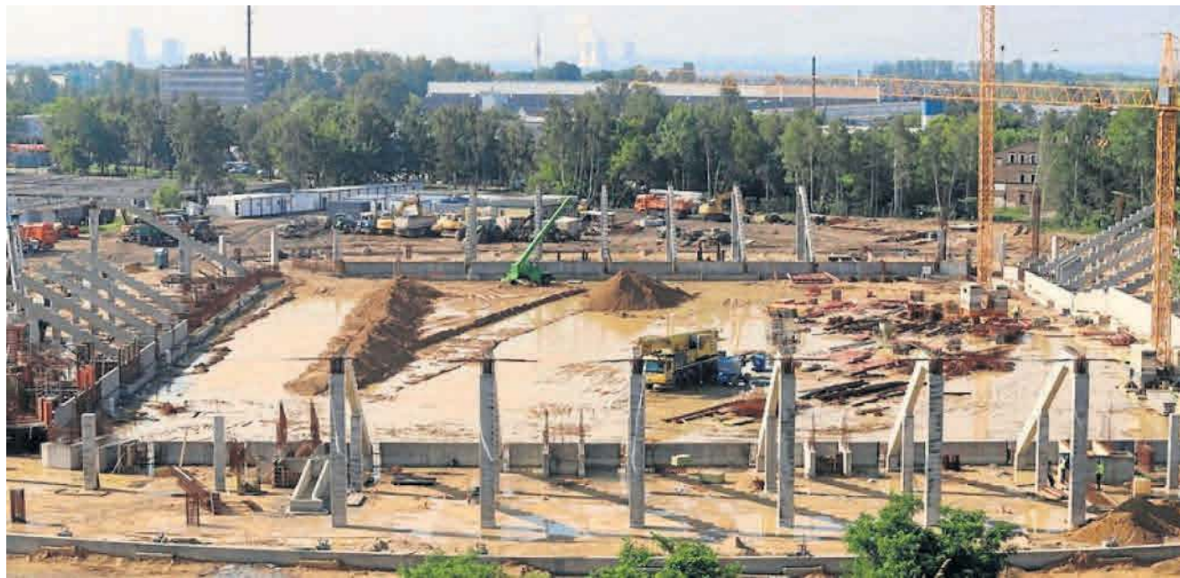
Tak obecnie wygląda plac budowy Zagłębiowskiego Parku Sportowego w Sosnowcu
