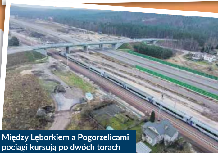
Nowy, dwukrawędziowy peron na stacji kolejowej Potęgowo
