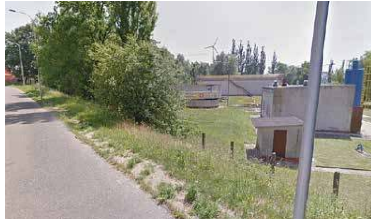
Nowogardzka oczyszczalnia przy ul. Zamkowej zaczęła pracę prawie pół wieku temu
