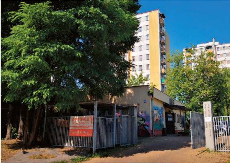
Dzisiaj przy ul. Łabędziej 15, w dawnym pawilonie handlowym, mieszczą się: Centrum Młodzieży „Nie lękajcie się” oraz Środowiskowy Hufiec Pracy. Za dwa lata, w tym miejscu oraz na pobliskim parkingu, wyrosnie nowe Centrum Kultury Bronowice
