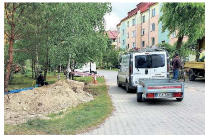
Układanie linii energetycznych umożliwiających wymianę oświetlenia na osiedlu
