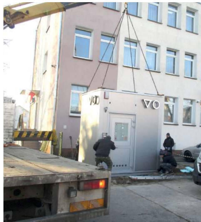
Nowoczesna automatyczna toaleta publiczna stanęła 21 stycznia w samym centrum Michowa, w pobliżu Urzędu Gminy i miejscowego Posterunku Policji
