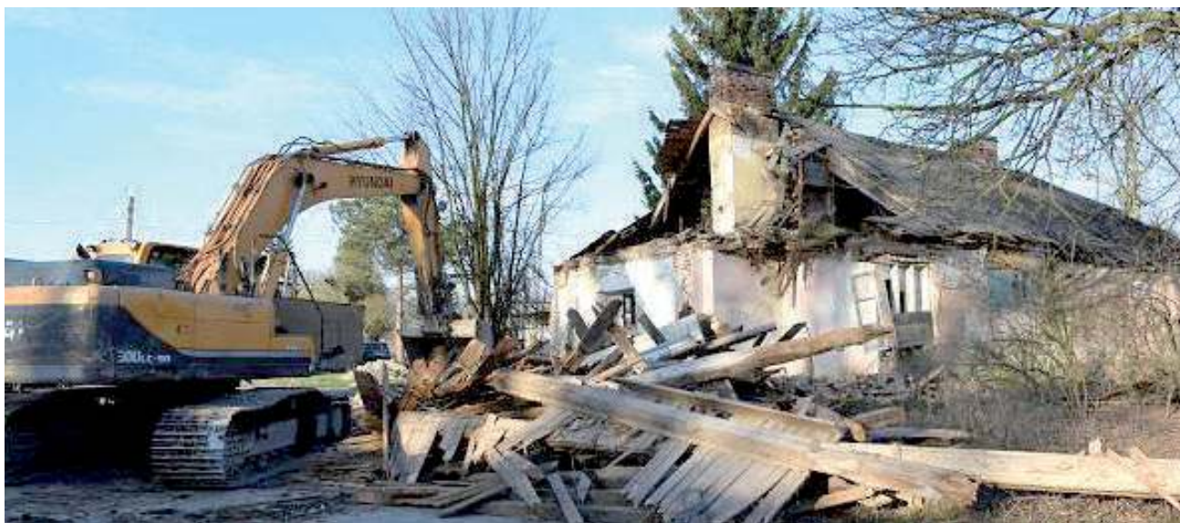
W Sernikach, 21 stycznia, rozpoczęły się prace przy wyburzeniu rządcówki i spichlerza. Wykonuje je firma PW Stachyra. Prace należą do rewitalizacji obszarów podworskich (centrum Sernik). Koszt to 4,8 mln zł, w tym 3,5 mln zł z UE, 395 tys. zł z budżetu państwa i 1,1 mln zł jako wkład własny gminy
