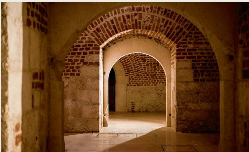
Wnętra renesansowych piwnic pod wschodnim skrzydłem pałacu
