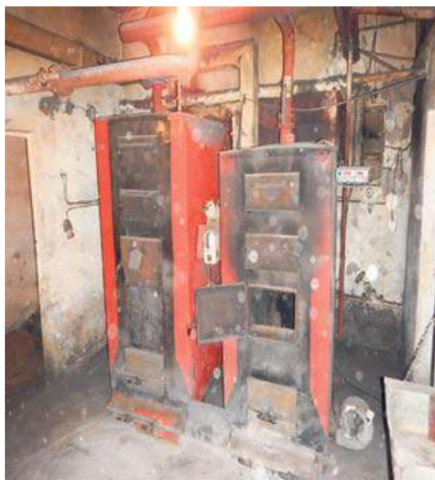
Rys.1. Kotłownia przed modernizacją. Kwiecień 2018 roku
