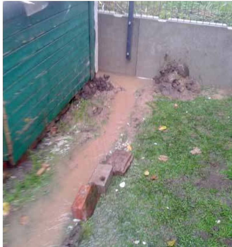
Działkowiec o zalanie oskarża pracowników budowy, która graniczy z działką sugerując, że ci wypompowują wodę
