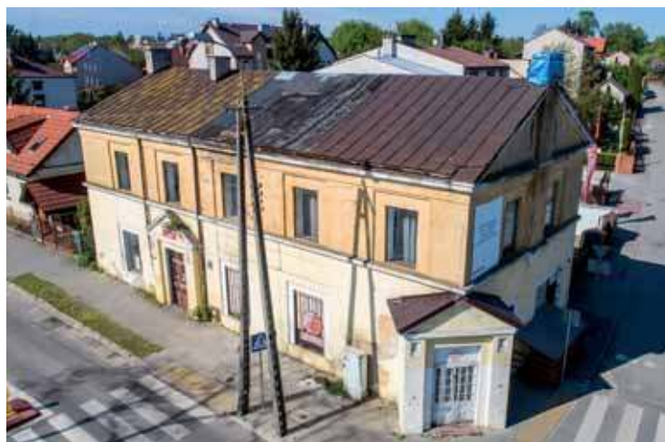
W budynku przy ul. Fabrycznej zostanie urządzony m.in. bar mleczny
