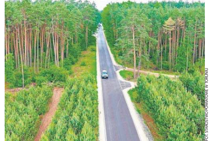
W minionym roku remont przeszła między innymi droga Czernikowo - Bobrowniki
