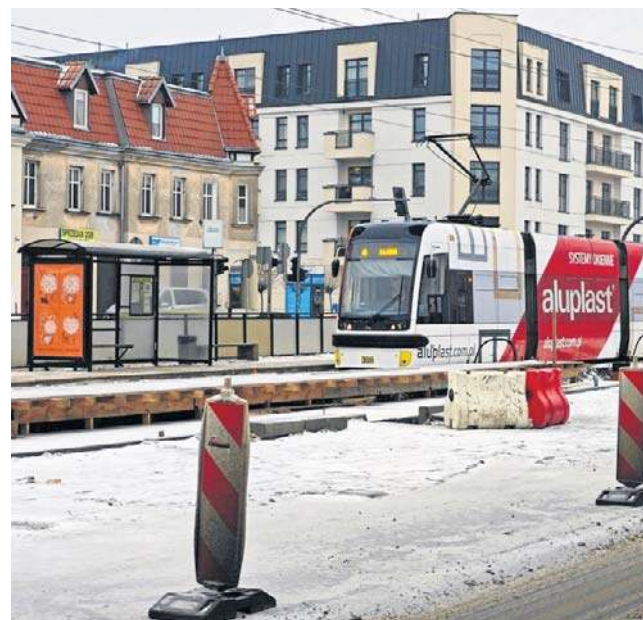
Zima wymusiła zatrzymanie robót przy przebudowie torowiska tramwajowego na ulicy Kościuszki
